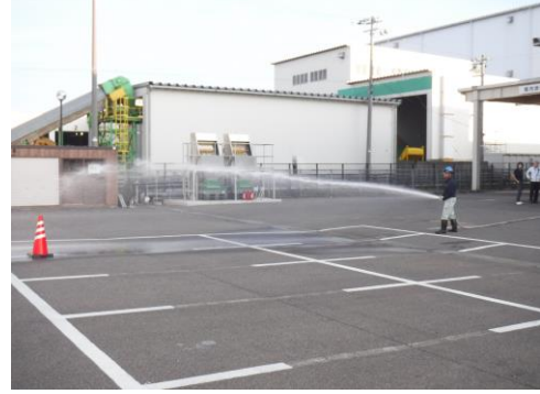
【消火栓の放水訓練】
