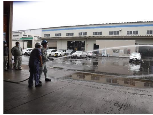
【消火栓の放水訓練】
