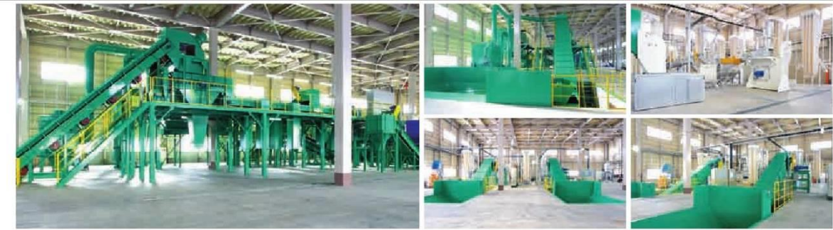
プラスチック再生施設
