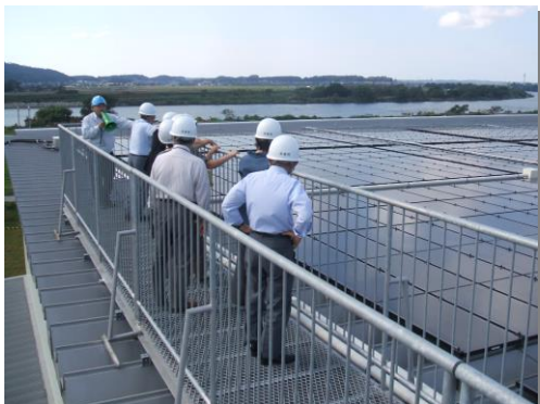
[発電設備見学の様子]
