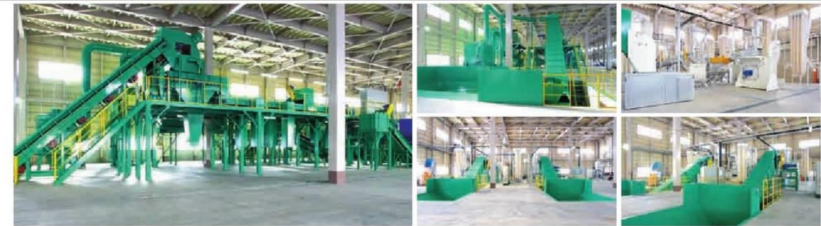
プラスチック再生施設
