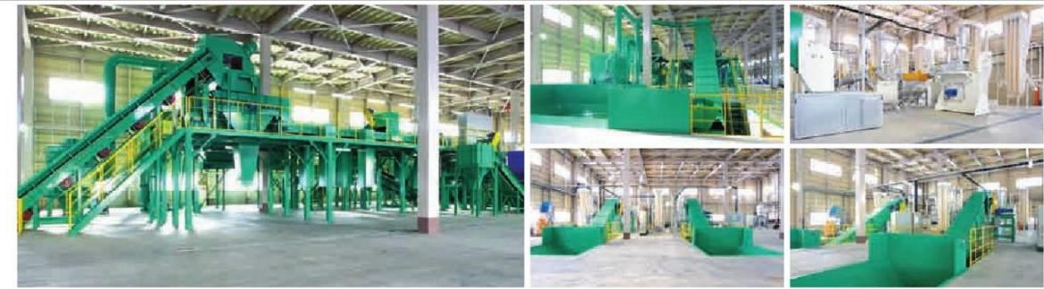
プラスチック再生施設
